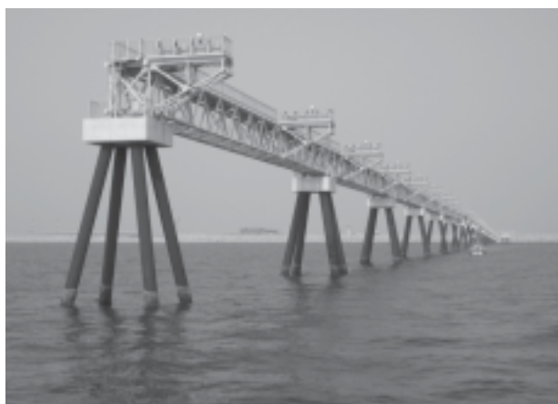
写真2 空港侵入灯橋梁
